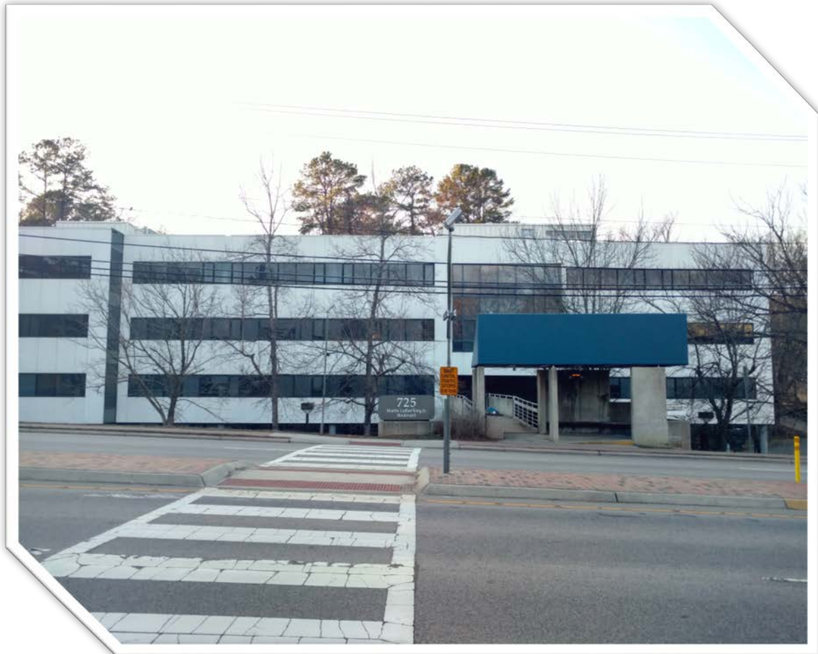
Imagen del exterior del edificio
